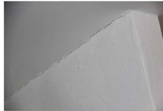
Figure 33 A2dr-cloison de la cuisine, fissuration des joints
