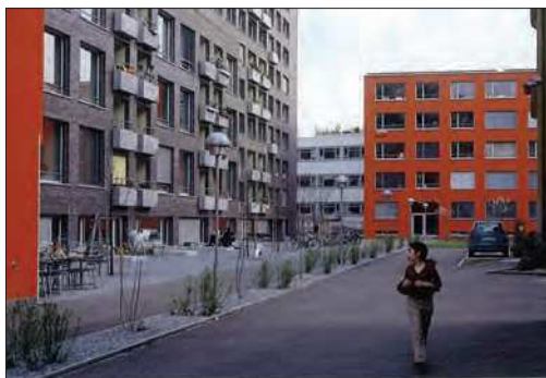
Kraftwerk, Zürich arch. Stücheli et Bünzli & Courvoisier, 2001
