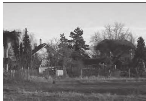
État actuel du site, photos GEA
