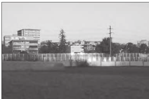
Paroi antibruit existante sur la limite Nord du site
